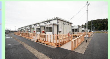
プレハブ住宅（輪島市完成事例）
