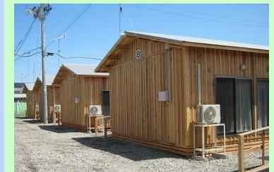
木造仮設住宅（設置例）
